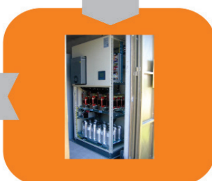
Isporuka i ugradnja opreme
